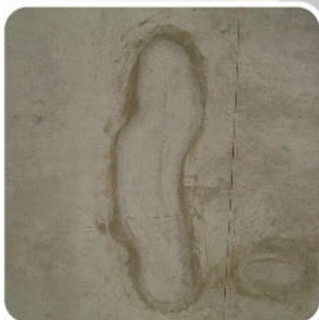
ผนังหลุดร่อน และฉาบเก็บงานไม่เรียบร้อย
